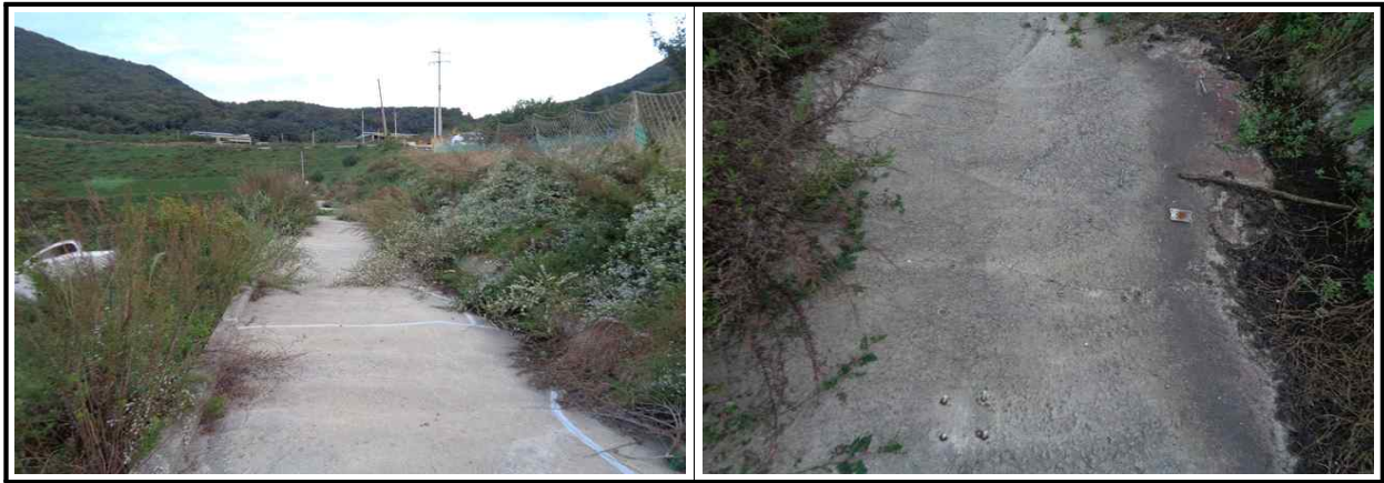
【그림 17.3.3】 배수시설 전경
